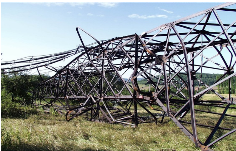
Obr. č. 4: Bouře (kulový blesk) - 14. 8. 2003 – zničení stožáru vedení V465
