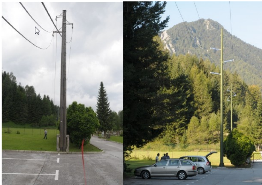
Obr. č. 14: Původní vedení 35kV a nové vedení 110kV.
