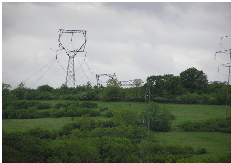
Obr. č. 3: Destrukce nosných stožárů typu Delta vichřicí
