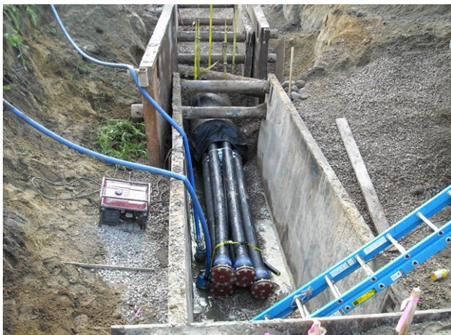
Obr. č. 8: Ukázka uložení kabelů vvn v zemi
